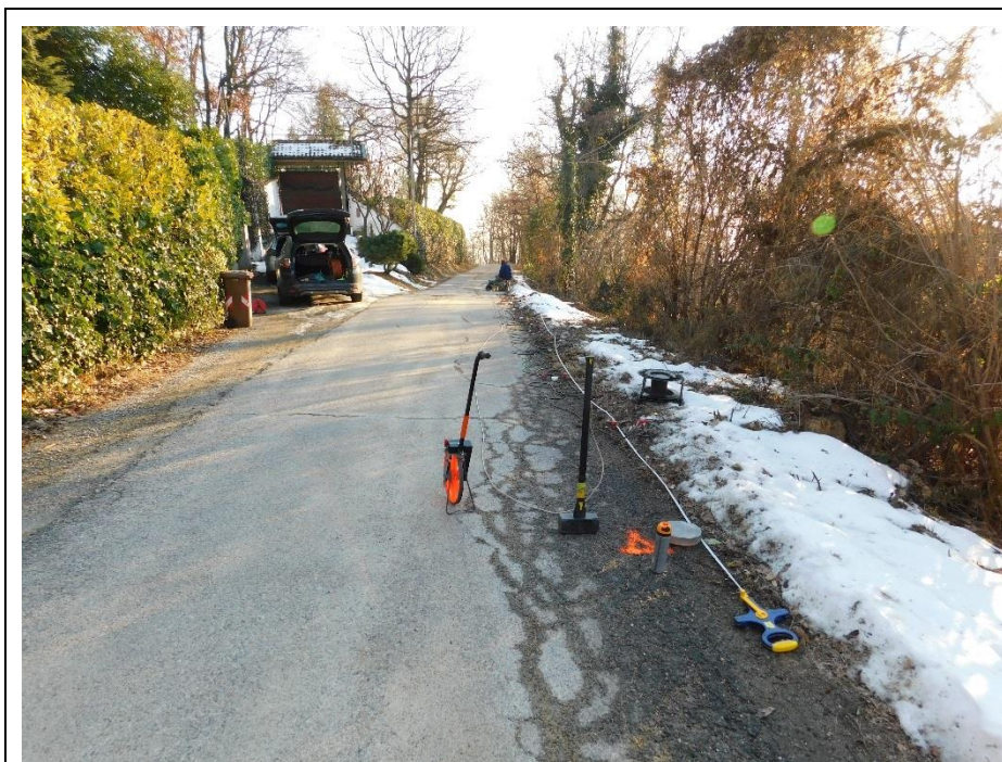
Foto 5. Vista strada oggetto di intervento
